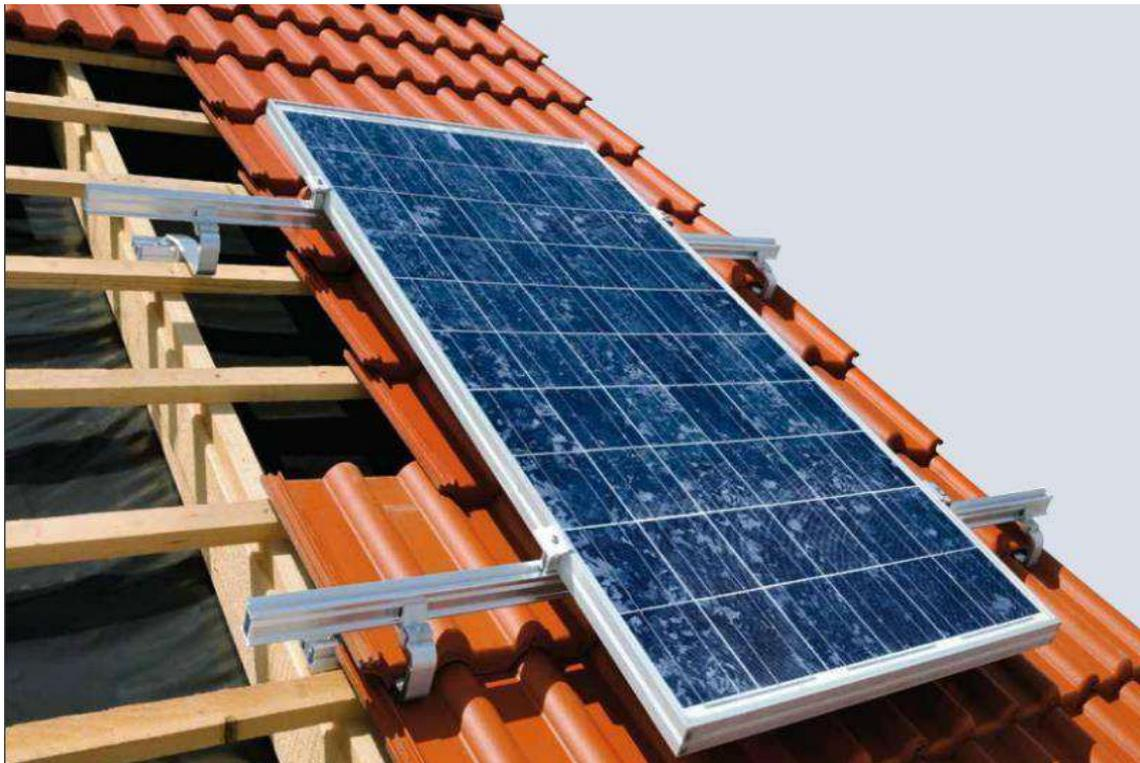
Befestigen Sie das nächste Modul mit der mittleren Klemme und das letzte Modul mit der Klemme.
