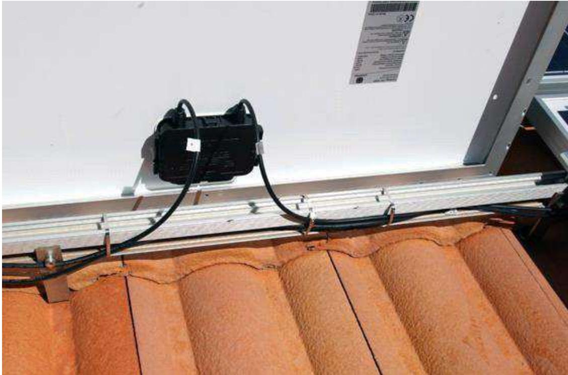
Bei Ziegeldächern müssen wir die Halterungen möglicherweise anpassen, da die Abmessungen der Ziegel bei verschiedenen Dächern unterschiedlich sind. Es gibt fertige Lösungen auf dem Markt, und unser erster Ansatz wäre, solche leicht verfügbaren Lösungen zu verwenden, um den Installationsprozess zu beschleunigen.
