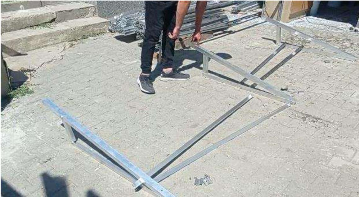
Bevor mit dem Zusammenbau der gesamten Anlage begonnen wird, empfiehlt es sich, einen einzelnen Bausatz zu montieren, um Positionsmarkierungen für die verschiedenen Komponenten vorzunehmen. Bevor mit dem Zusammenbau der Struktur begonnen wird, ist zu prüfen, ob alle erforderlichen Komponenten und Werkzeuge für den Beginn des Prozesses bereitstehen.
