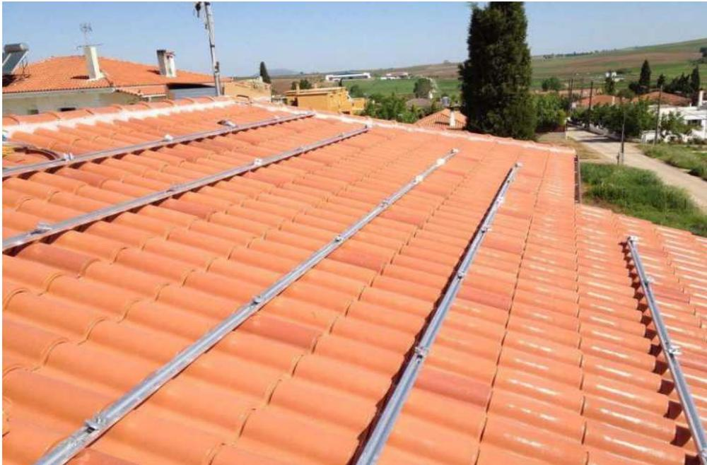
Die Montageschienen werden mit Hilfe von Befestigungsmitteln mit den Halterungen verbunden.
