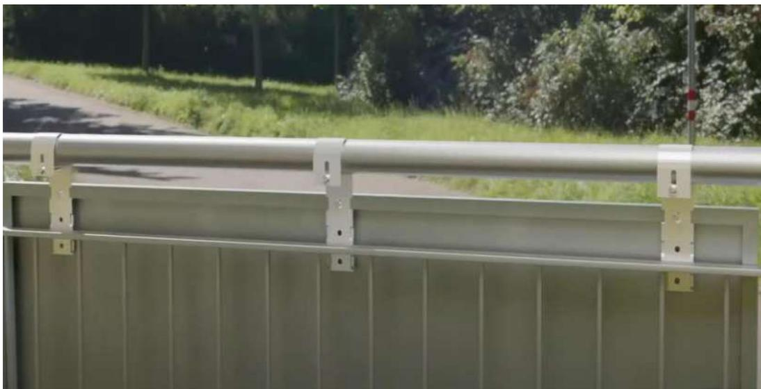
Jeweils eine vormontierte Modulendklemme rechts und links in die Schiene schieben und ganz an das Modul heranführen, das Modul ausrichten und die Klemmen zusammenschrauben.
