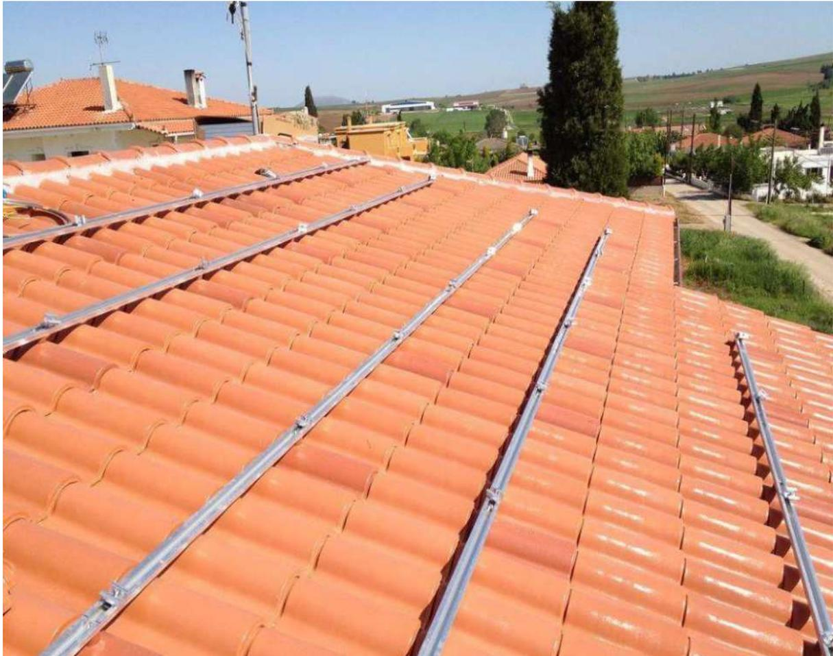
Dachziegelkonsolen müssen mit Schrauben an einem Dachstuhl befestigt werden. Die Unterseite des Ziegels wird abgeschliffen, damit der Ziegel nach dem Schließen flach aufliegt.
