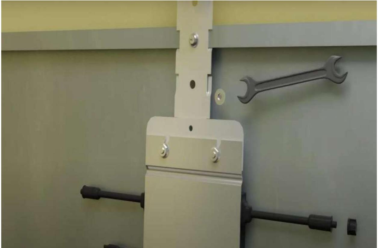
Schrauben Sie den Wechselrichter an die Halterung des Balkongeländers.
